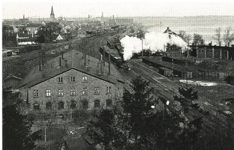
Helsingør Banegårdsområde, således som det tog sig ud fra broen ved Flynderborgvej omkring århundredeskiftet. Forrest til venstre ses den ældste remise fra 1891, mens den nye remise, der byggedes i forbindelse med Kystbanens åbning, ses til højre i billedet. (Helsingør Bymuseum).
