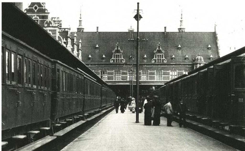
Helsingør station efter at stationen var ombygget til også at kunne modtage Kystbanens tog. Bemærk at vognene er af den type, hvor togkonduktøren skulle gå udenpå toget for at billettere. (Helsingør Bymuseum).
