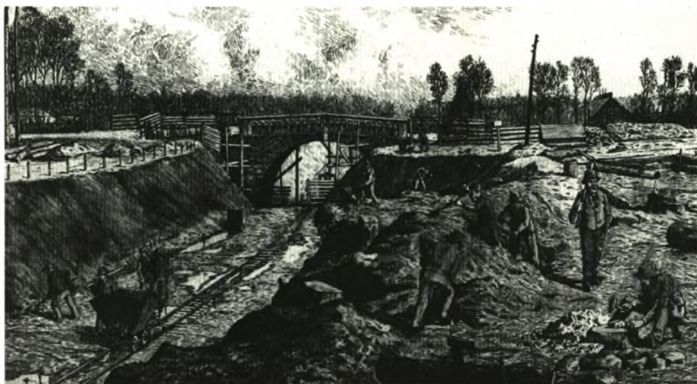
Viadukten nord for Klampenborg Station under opførelse i 1896. ("Hver 14. Dag", 1896/97, side 76).
