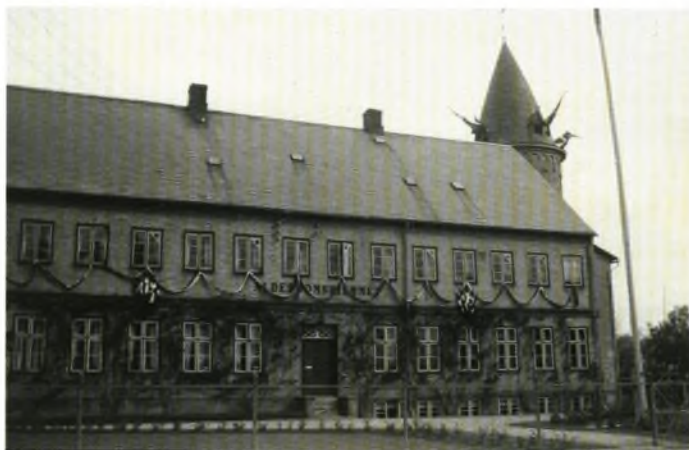
Som nabo til datidens rådhus, hvor Valdemar Seeger havde sin arbejdsplads, lå på Tinghusvej 4 "Forsørgelsesanstalten", hvor han boede. Senere blev ejendommen kendt som "Alderdomshjemmet" og fungerede som sådan frem til 1985, hvor bygningen fungerede som en del af rådhusets funktioner. Fredensborg Arkiverne.
