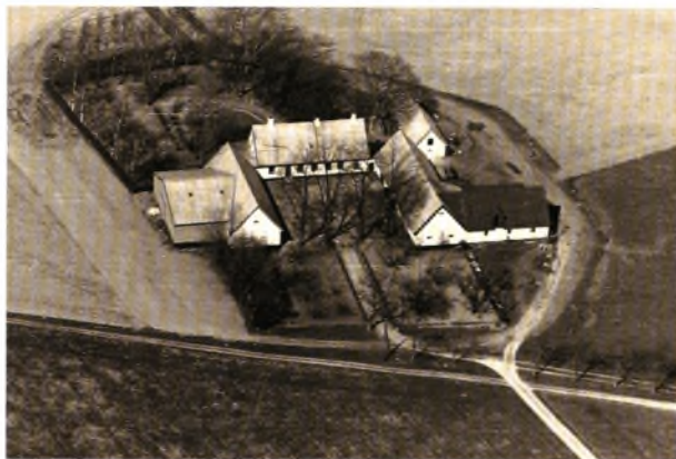
Bivumgård blev nedrevet i forbindelse med opførelsen af Torpen Kapel. Fredensborg Arkiverne
