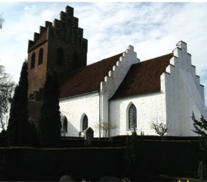
Grønholt Kirke har bygningslementer, der stammer fra 1100-tallet og frem til 1600-tallet, hvor støttepillen til højre blev tilføjet. Om kirken skulle falde uden den, vides heldigvis ikke.
