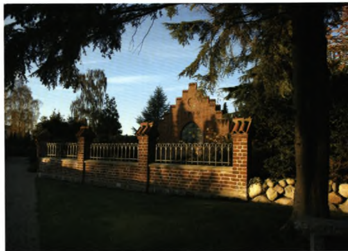
Mure omkring eller på kirkegårdsanlæg kan som her være af kampsten eller mursten.
