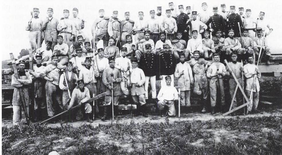
Fig. 50. I jernbanernes første mange årtier var de militære institutioner af største betydning for udviklingen. I mange tilfælde var det da også kun her, at den fornødne tekniske ekspertise var til stede. Dette gjaldt især i forbindelse med anlægsarbejder. På billedet er det jernbanekompagniet under Hærens Ingeniørkorps, som deltager i – eller nok snarere øver sig under – anlæggelsen af Slagelse-Vårslev-banen, der åbnede som statsbane i 1898. Materiale vedrørende statsbaneanlæg findes bl.a. i DSBs arkiv – og altså også i forsvarets arkiver – på Rigsarkivet. (Lokalhistorisk Arkiv, Høng Bibliotek).
