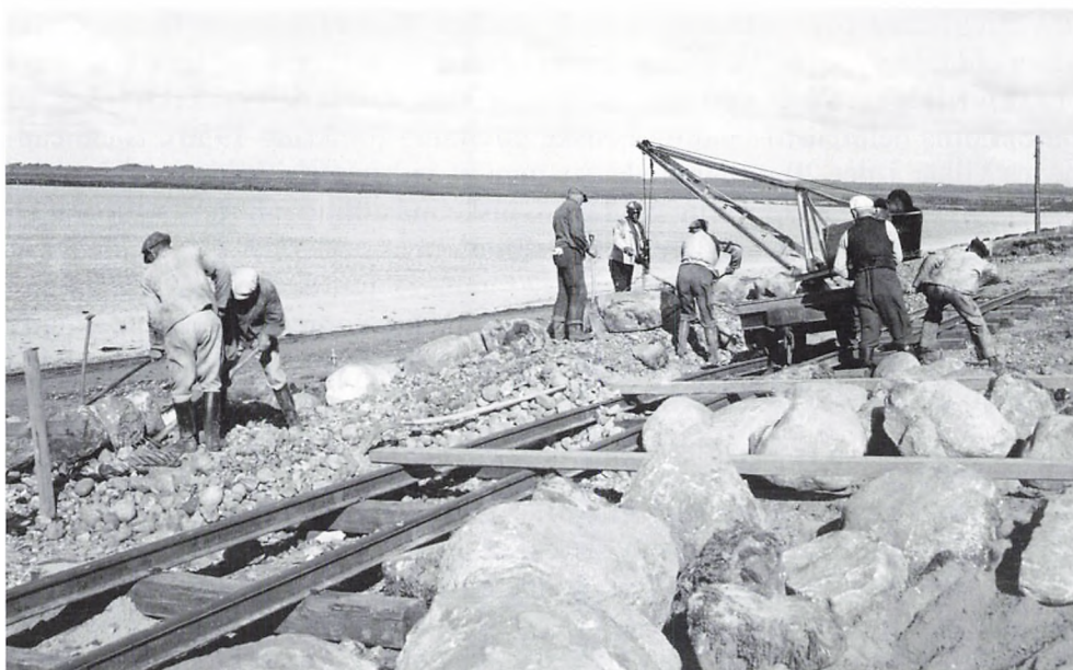
Fig. 78. Rømødæmningen, der forbinder vadehavsøen Rømø med fastlandet, blev påbegyndt i slutningen af 1930'erne som et beskæftigelsesarbejde. På grund af 2. verdenskrig afsluttedes projektet imidlertid først i 1948. Her ses man i gang med anlægsarbejdet. (Museum Sønderjylland. ISL-Lokalhistorie).
