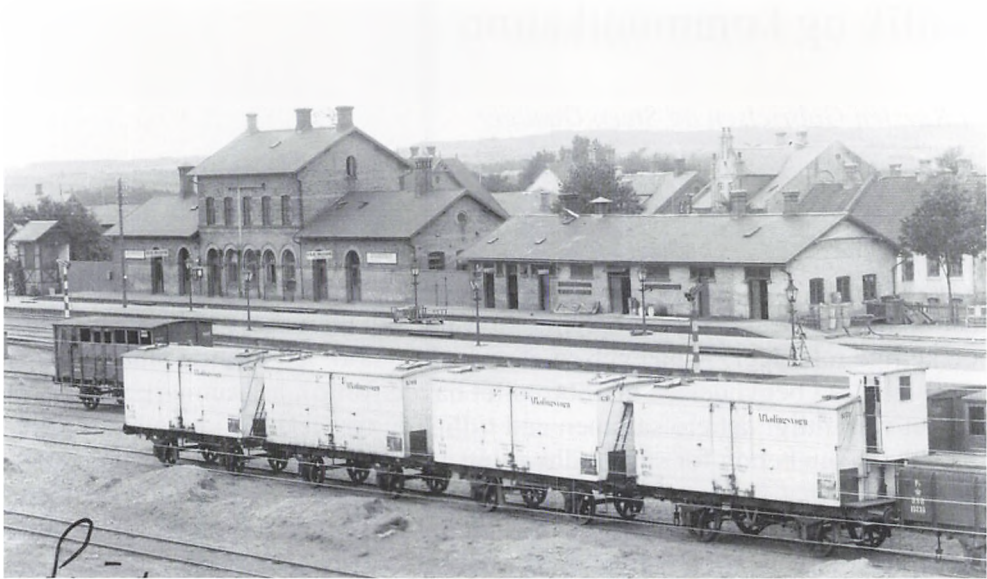
Fig. 49. Kølevogne på Lunderskov Station i 1903. Vognene blev brugt til transport af letfordærlige varer som kød og flæsk til bl.a. udskibning og eksport fra Esbjerg Havn. Sammen med tværbanen fra Lunderskov blev den anlagt som led i den store politiske satsning, der skulle styrke Danmarks forbindelse med England og landbrugseksporten. Kilderne hertil skal bl.a. søges i den såkaldte e- eller jernbanejournal, der fra 1849 og frem til ca. 1970 var hoveddrygraden i den ministerielle sagsbehandling vedrørende jernbaner. (Foto fra F.C.J. Gusmers album, Danmarks Jernbanemuseum).
