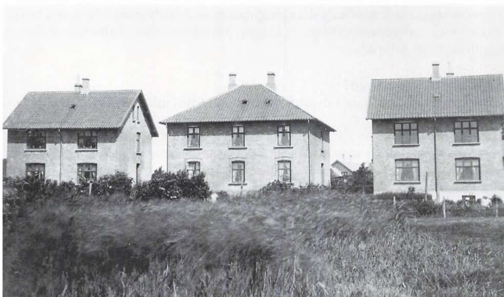
Fig. 96. Bygninger i den lille tolderby i Hals, med toldkontrol og fire huse med hver to tjenesteboliger. De blev opført efter, at der i 1896 var anlagt en fyrlinje gennem Limfjorden, således at sejlads kunne foregå hele døgnet. Skibenes stoppepligt ophørte imidlertid allerede i 1911, og flere af husene blev herefter afhændet, det sidste dog først i 1973. (Told • Skat Museet).
