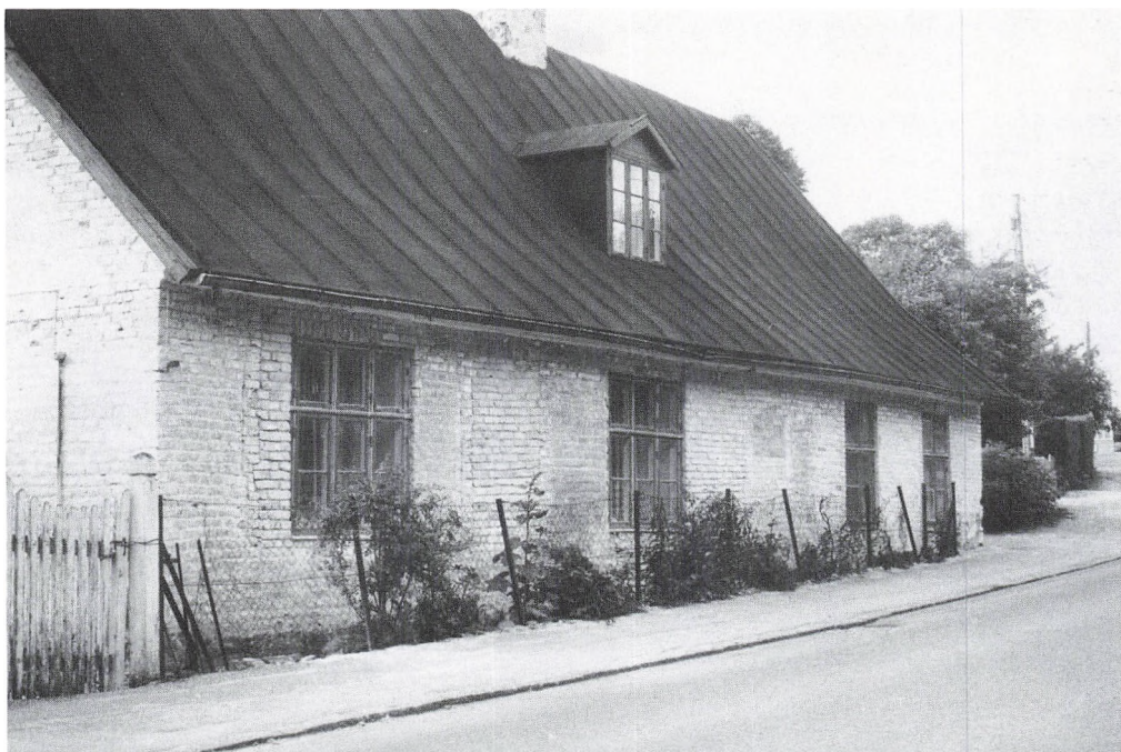
Den gamle rytterskole i Tikøb eksisterer endnu. Bygningen opførtes i 1722, men er naturligvis ændret flere gange siden. På dette foto er pudset pillet af, og man ser tydeligt hvor de oprindelige vinduer og døre har været placeret. Det er også meget tydeligt at se, hvor den gamle rytterskole-tavle har været placeret, nemlig mellem de nuværende to midterste vinduer. (Foto: Ulla Bang, Espergærde).
