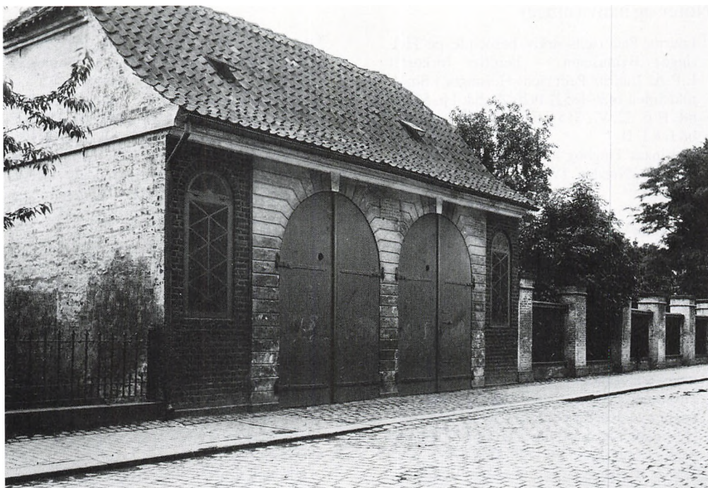
Ligbærerselskabets vognhus i Nygade blev opført i 1824. Fot. Hugo Matthiessen, 1919.
