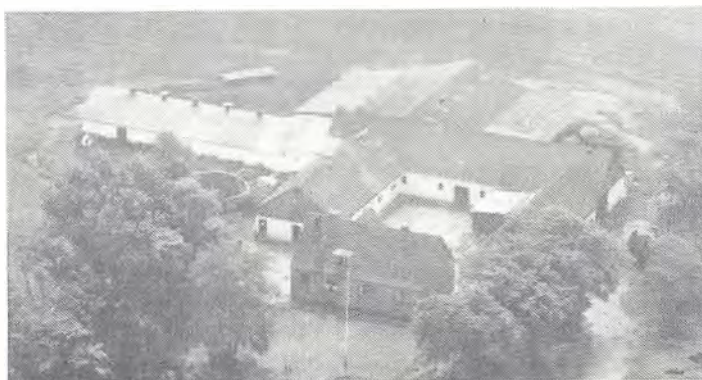
Foto: Kastrup Luftfoto.
