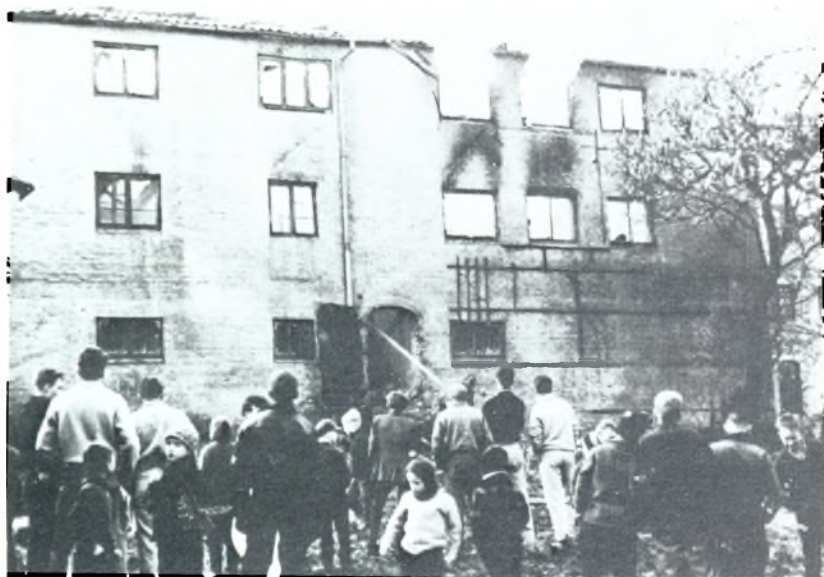
Efter en brand i 1960'erne i Ramsherred 39, blev flere bygninger revet ned, og gårdspladsen og bygningerne brugtes ikke længere til vareoplagring.
