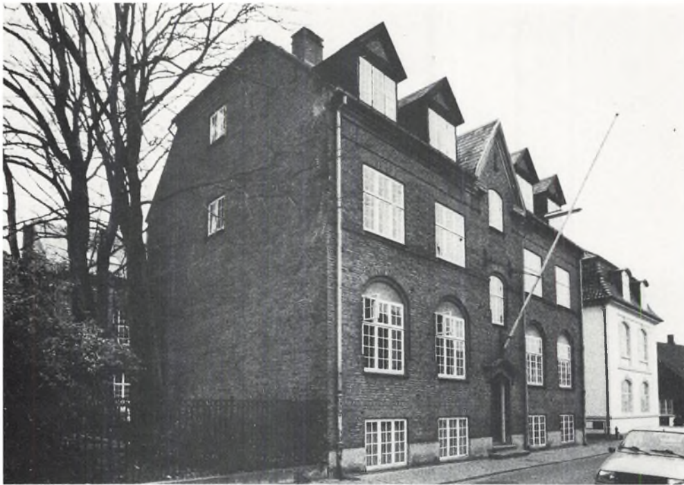
Teknisk skoles forhus i Møllestræde. Det blev opført i 1909 som elevhjem og forstanderbolig.
