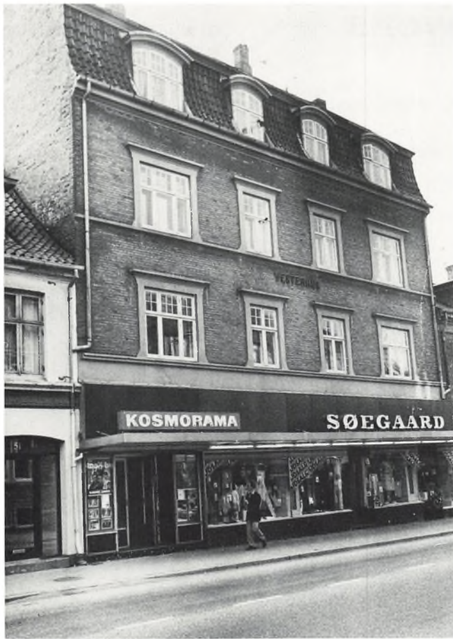
Vinhandler Charles Petersen købte i 1912 »Sorte Hest«, lod ejendommen rive ned og opførte i stedet »Vesterhus« med biografen Kosmorama, der ligger der den dag i dag.
