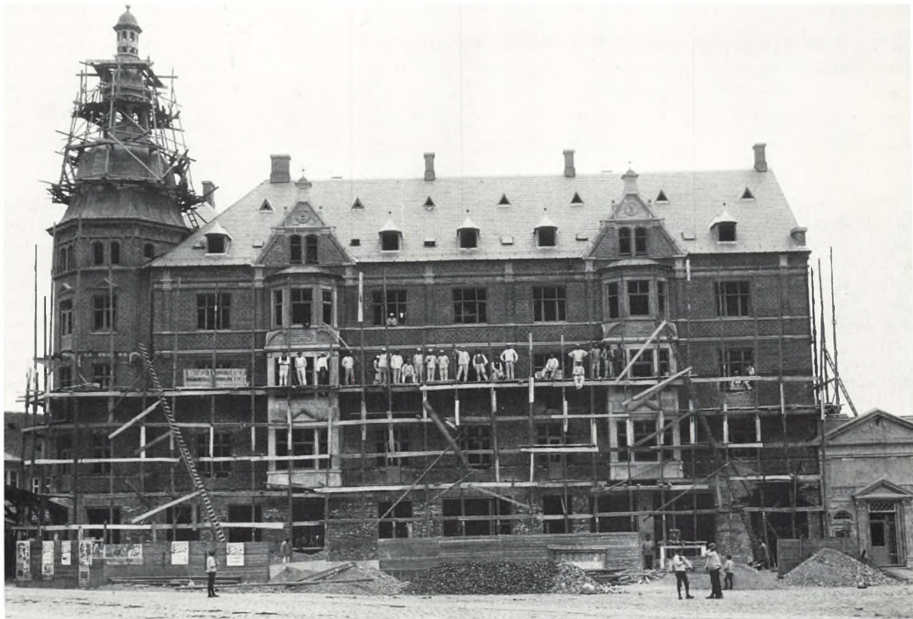
Et af Hillerøds store bygningsværker, som Vilhelm Holck stod bag var opførelsen af Bankbygningen på Torvet. Her er håndværkerne fotograferet kort før bygningens færdiggørelse i 1908.
