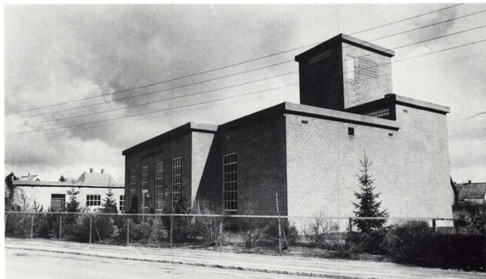
Nyhuse Vandværk 1980 - en stor markant murstens bygning. I dag forsyner vandværket omkring 5-6000 mennesker med vand.
