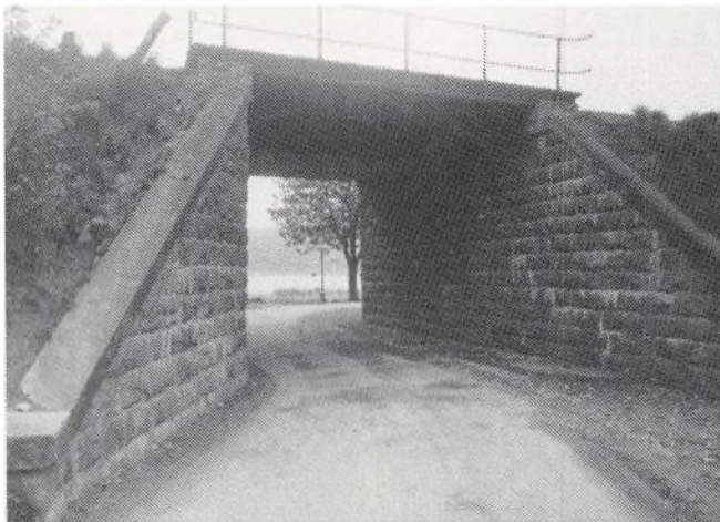
Tunnelen, der tidligere førte Hammersholtvej under baneterrænet. Billedet er taget fra Hillerød-siden og i tunnelens åbning ses Teglgårdsøen.
