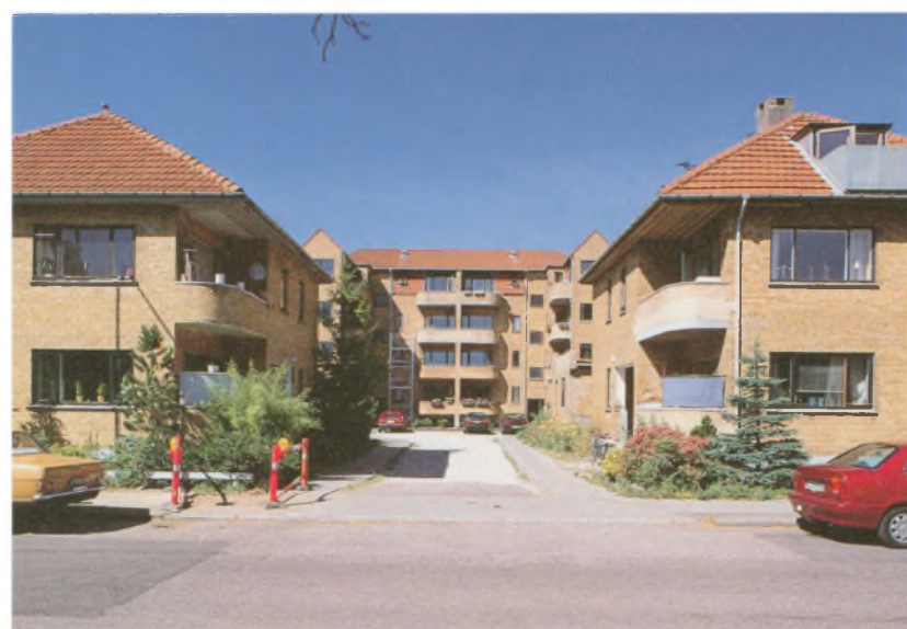
Den lille etagehusbebyggelse, Frejasvej 16, blev opført i 1937. Bebyggelsen er i gule mursten med røde tegl på taget og anlagt omkring en lille stikvej. Mod Frejasvej ligger toetages punkthuse og for enden af stikvejen en firetages boligblok. Facaderne er enkle, hvor den eneste dekoration er de rundede balkoner. En typisk lille funktionsbebyggelse.
