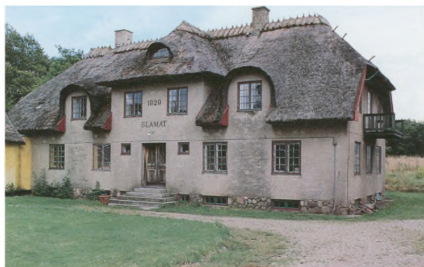
Slamat, Slammatvej 4, blev opført i 1815. Hovedhuset blev ombygget til nuværende udseende i 1929. Murene er pudsede og taget er tækket med strå. Facaden er symmetrisk omkring indgangsparti og en tofags frontkvist, men ikke specielt harmonisk. Rundbuede kviste pryder det særegne hus inspireret af sydligere himmelstrøg.
