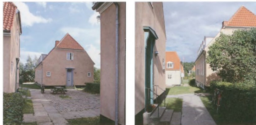
Fra det nordlige afsnit. Dobelthusene har indgang i gavlen, indfattet i træværk med konsoller der bærer et buet overstykke. Bygningerne er restaureret for nylig og fremstår i douce farver mellem det røde tegltag og den sortmalede sokkel.
