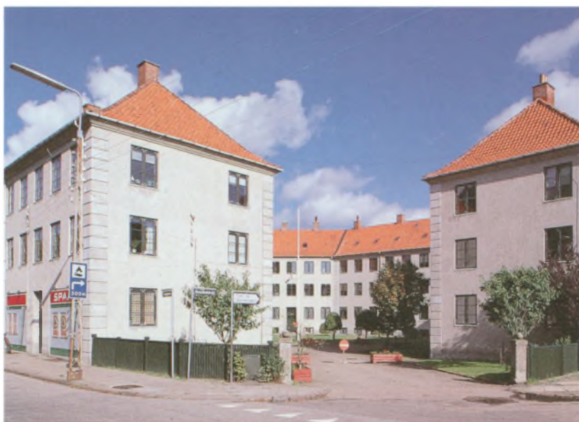
Etageboligbebyggelsen Lappen 2, blev opført i 1923-24 af Arbejdernes kooperative Byggeforsening. Facaderne er pudsede, og der er tegl på taget. Eneste dekoration er kvaderpudsede hjørnelisener. Bebyggelsesplanen er åben og forsøger at leve op til tidens krav om store parkagtige gårdrum. En fin nyklassicistisk bebyggelse, hvor de to gavle spiller op til hinanden og giver mulighed for at kigge ind i gårdrummet.
