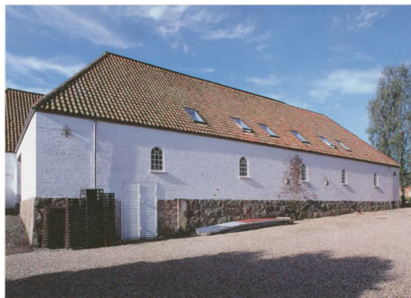
Gjørlundegaard, Skibstrupvej 20, fin staldbygning i kalket mur, med kampestens-sokkel og smukt tegltag, opført i 1890. Rundbuede vinduer med jernrammer pryder den rene, næsten strenge klassicistisk inspirerede bygning.
