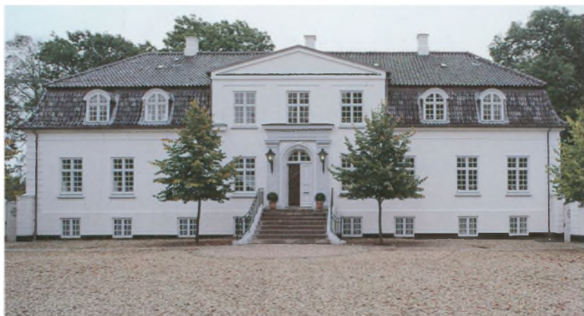
Danstruplund, oprindelig Landlyst, Danstrupvej 25, blev opført i 1867, men virker umiddelbart yngre i sit udtryk. Hovedbygningen er pudset og hvidmalet med sort-glaseret mansardtag. Facaden mod gården er symmetrisk omkring frontkvist og indgangsparti. Indgangspartiet er yderligere fremhævet med portal og paradetræppe. En fornem hovedbygning med klassicistiske træk.
