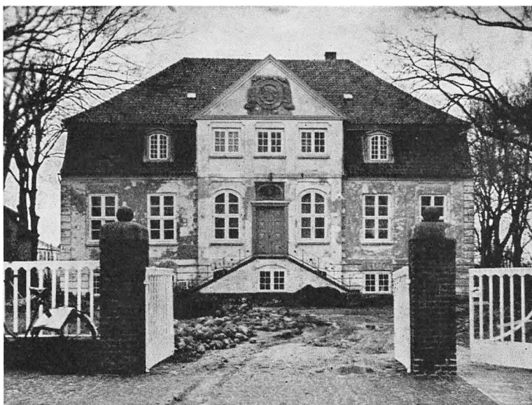
Figur 4: Amtmandsboligens facade, fotograferet under restaureringen 1950
