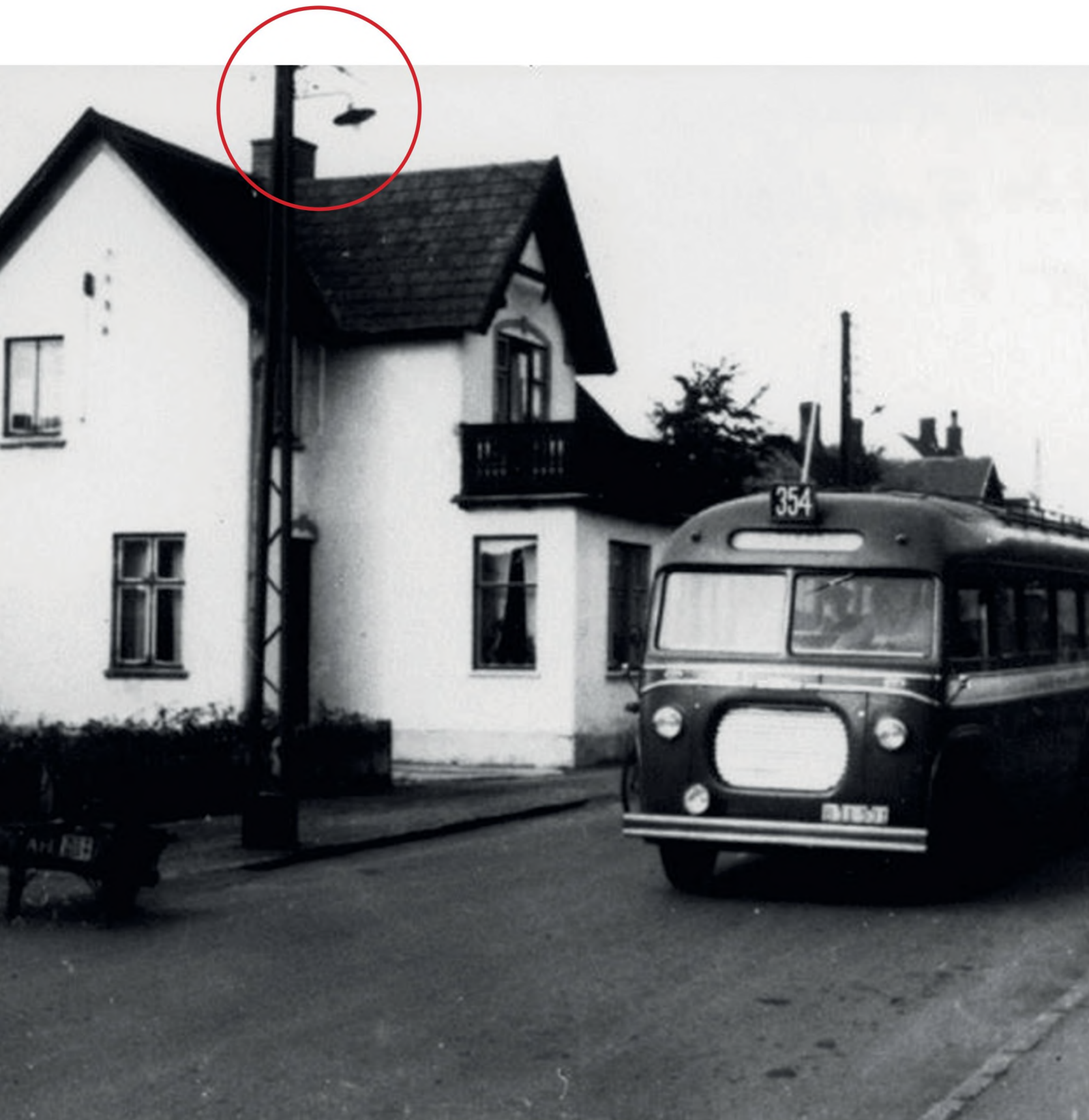
Græsted Hovedgade ud for nr. 18 år 1955. Vekselstrømsluftledningsanlæg ses på jerngittermast med glødepære som gadelys. Foto: Gribskov Arkiv.
