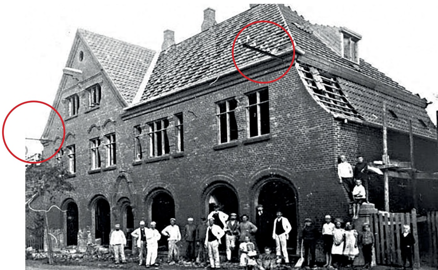
Købmandsbutikken Østergade 12, Helsingør, år 1910, med ledninger fra Helsingør Elværk under tagrenden. Foto: Gribskov Arkiv.
