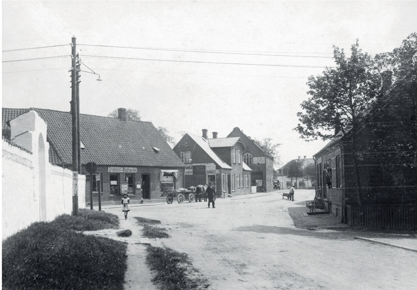
Græsted Hovedgade ud for nr. 1 år 1922. Jævnstrøms-luftledningsanlæg på træmaster og med glødepærer som gadebelysning. Foto: Gribskov Arkiv.
