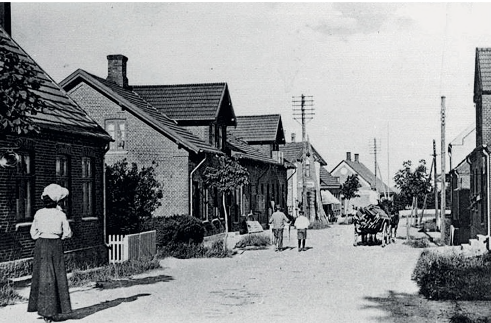
Græsted Hovedgade ud for nr. 21 år 1910. I masterne ses jævnstrøms-forsyningsnet til højre i billedet og telefonledninger til venstre i billedet. Foto: Gribskov Arkiv.
