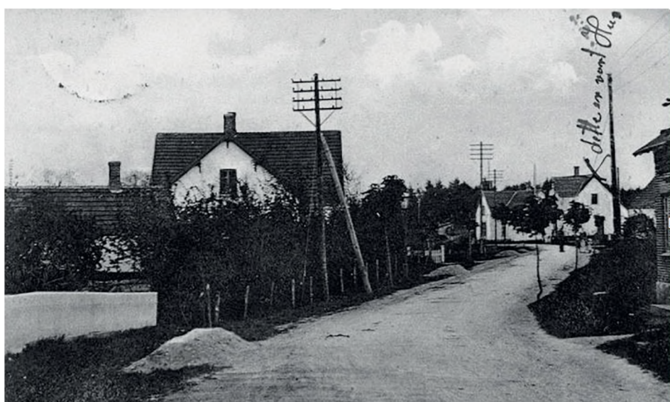
Græsted Hovedgade ud for nr. 48 år 1919. I masterne ses jævnstrøms-forsyningsnet til højre og telefonledningsnet til venstre. Foto: Gribskov Arkiv.
