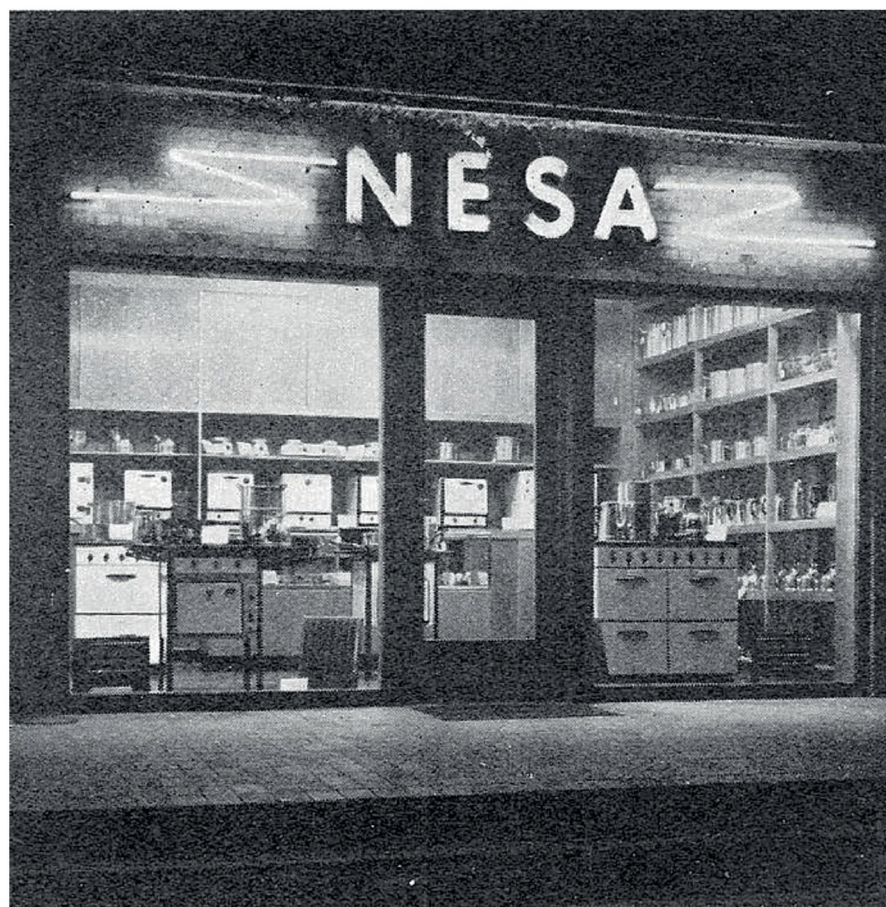
Elinstallatør Christian Diderichsens forretning på Frederiksborgvej indrettet som NESA-butik og på facaden forsynet med NESA's navn. Foto: NESA's personaleblad i 1950
