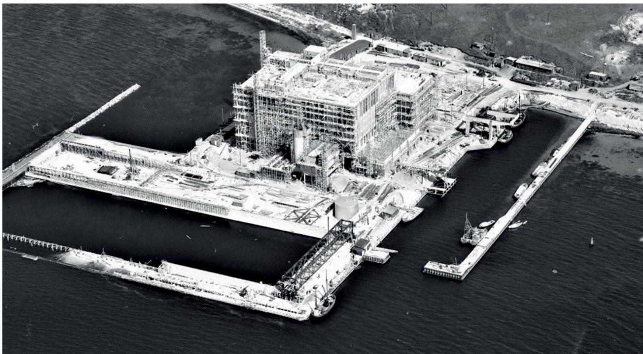
Isefjordværket ca. 1939 - det senere Kyndbyværk. Opført af NESAs og taget i brug den 3. april 1940. Foto: Sylvest Jensen/Det Kgl. Bibliotek.
