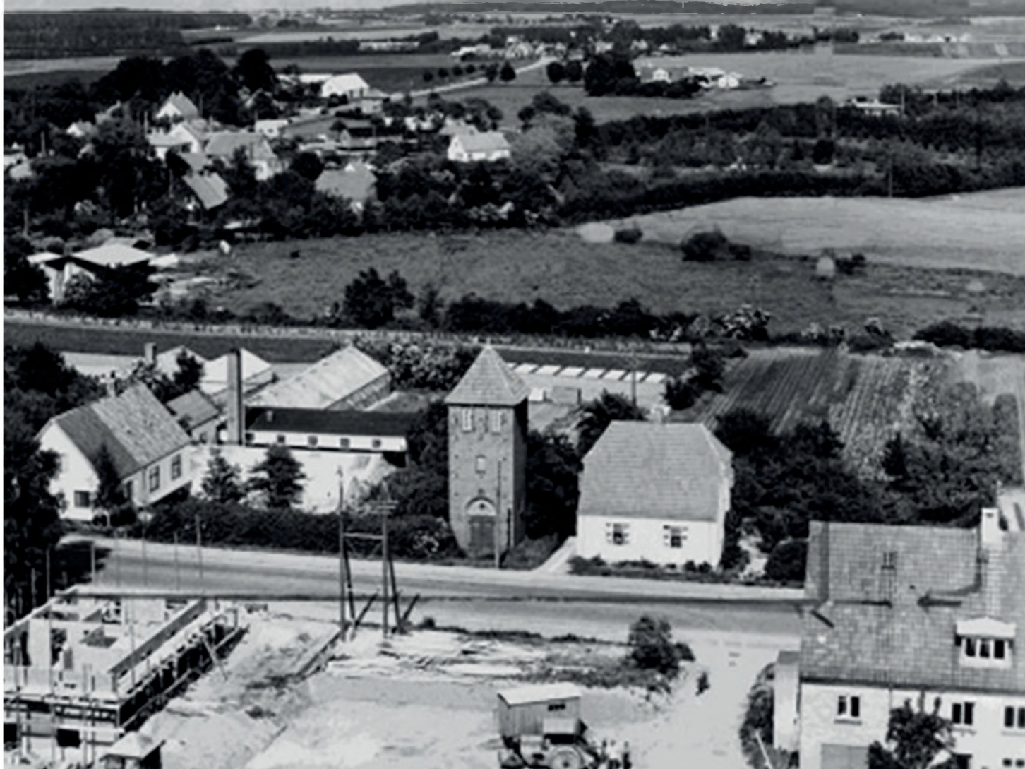
Midt i billedet koblingsstation på Frederiksborgvej i Helsingør år 1956. Foto: Sylvest Jensen/Det Kgl. Bibliotek.
