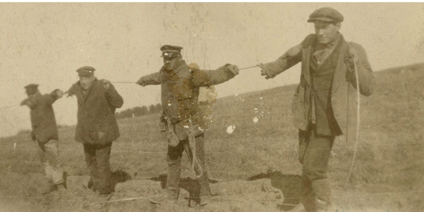
Ledningshold fra NESA under arbejde med etablering af luftledninger, år 1920-1930. Foto: Gentofte Arkiv
