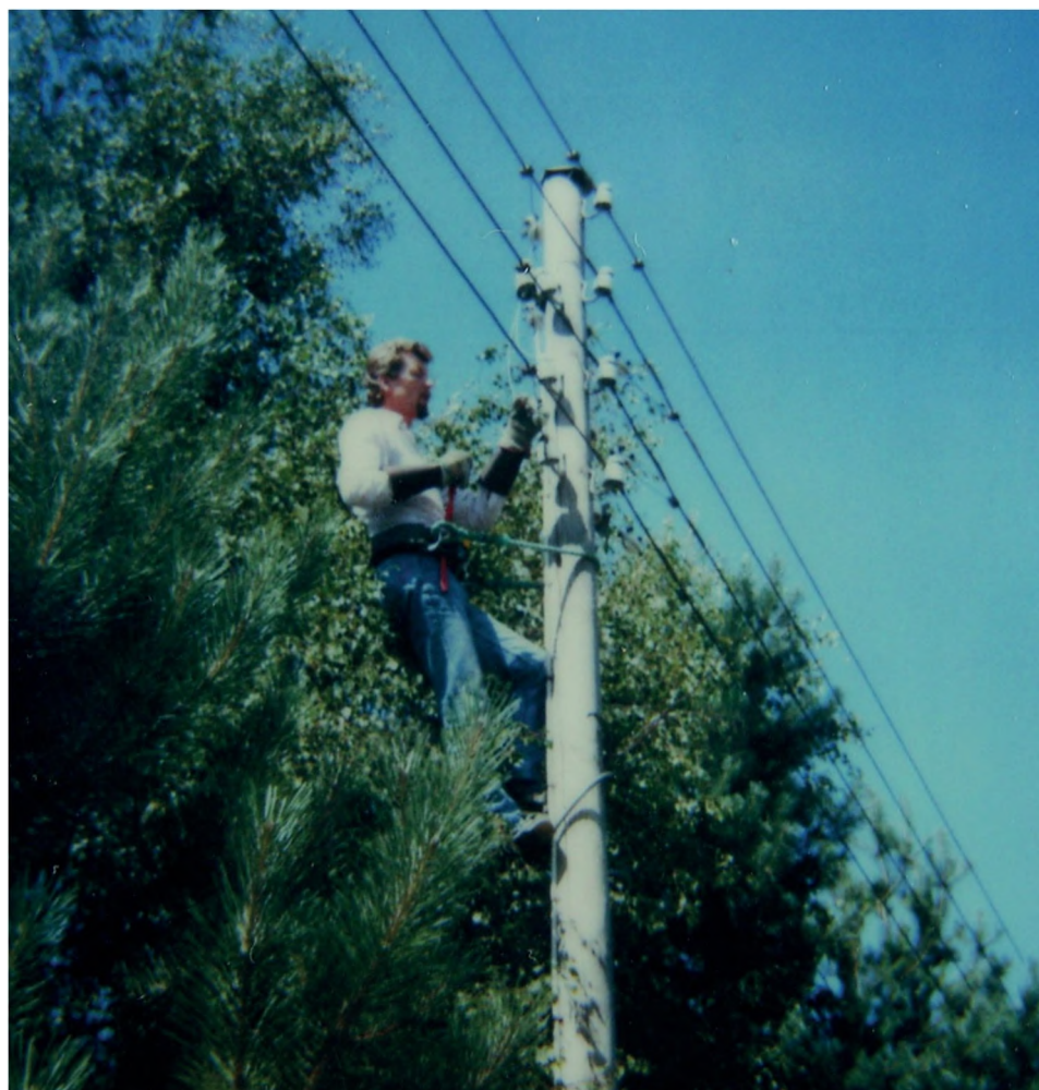
NESA distriktsvagt Jørgen Lindehøj under udskiftning af sikring i elmast år 1988. Foto: Privat udlån.
