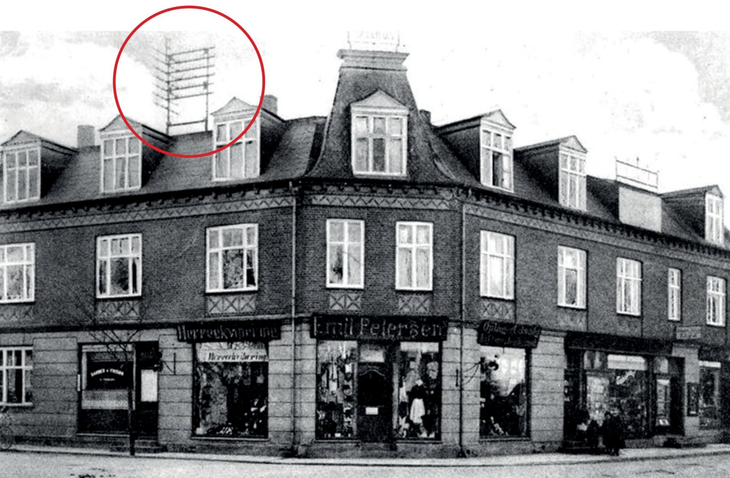
Ejendommen Axelhus på hjørnet af Frederiksborgvej og Vestergade, Helsingør. - På taget ses Helsingør Elværk's koblingsanlæg. Foto: Gribskov Arkiv.
