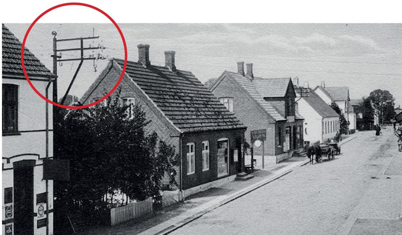
Græsted Hovedgade ud for nr. 25 år 1930 el-forsyningsinstallationer på master og husbeslag. Foto: Gribskov Arkiv.
