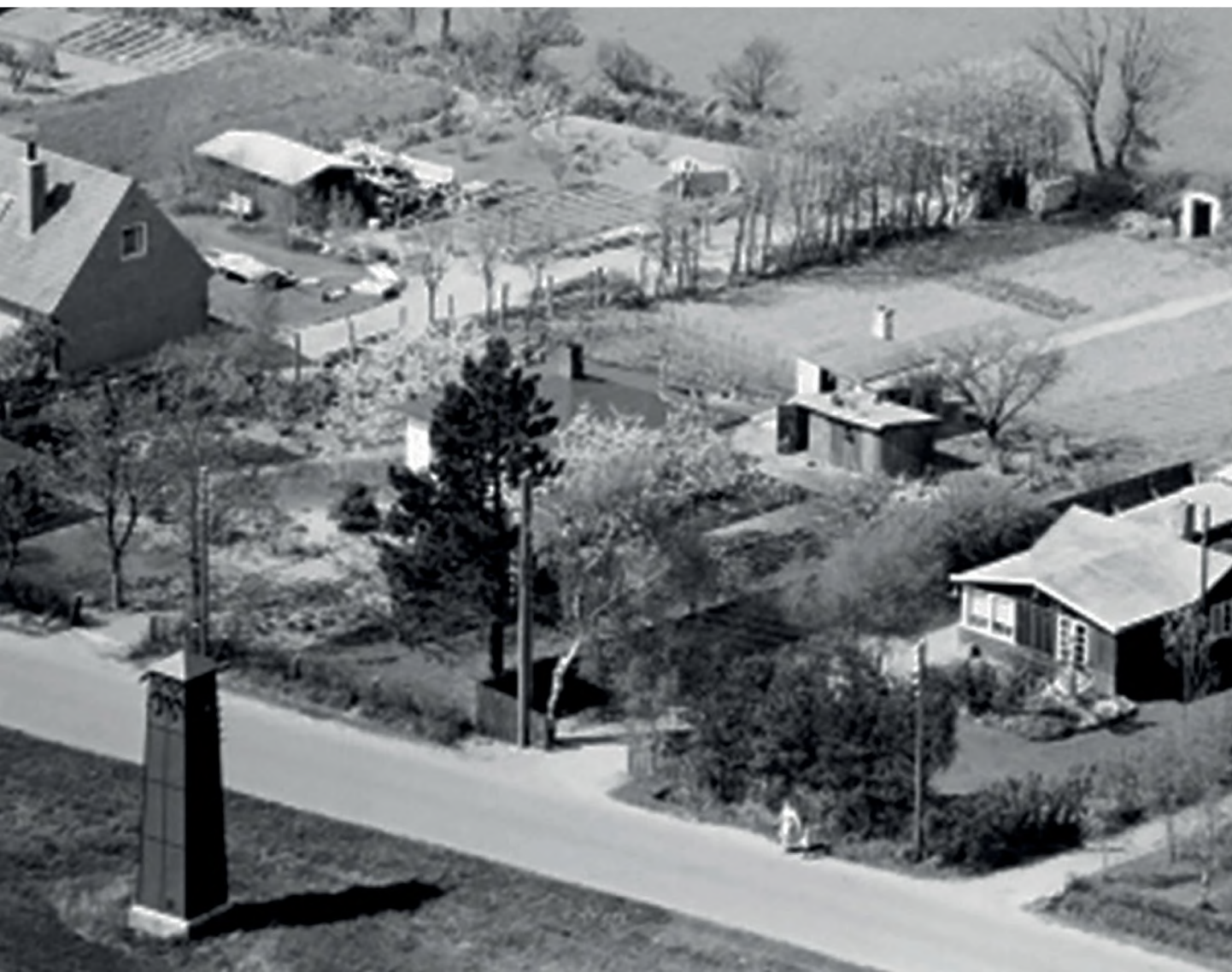
Transformatorstation Bækkebrovej, Tibirke. Foto: Sylvest Jensen, Det Kgl. Bibliotek.
