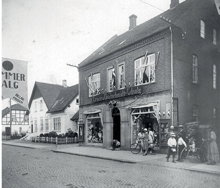
Forretningsejendommen Østergade 34 i Helsingø med jævnstrømsfor-syn- ningsledninger fremført på gavlbreslag. Foto: Gribskov Arkiv.
