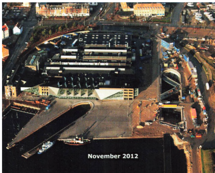
Søfartsmuseet under bygning og brolægning af værftsplads pågår. Foto: Jan Kofod Winther.
