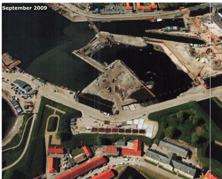
Scholtens Ravelin er ved at tage form september 2009 og genopførelse af Kulturværftets bygning 13 er i gang. Foto: Jan Kofod Winther.
