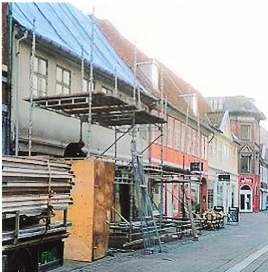
Byggeplads på Stengade.
