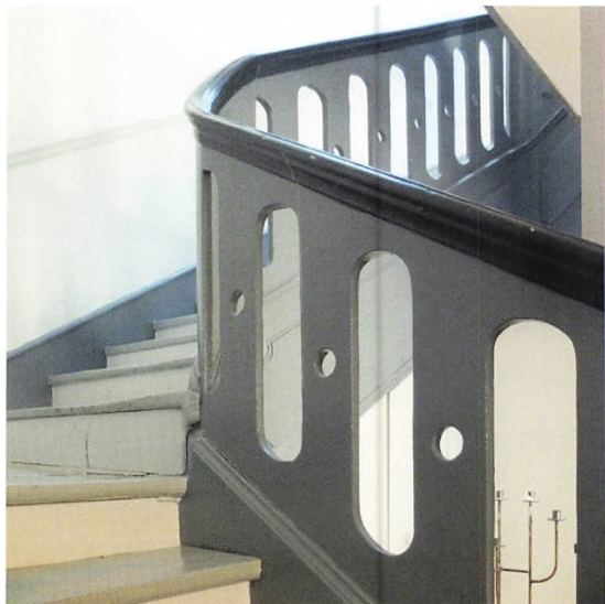
Den renoverede baroktrappe.
