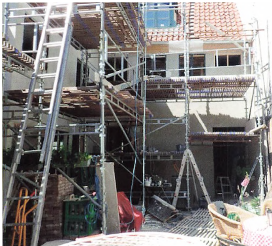
Byggeplads i gården.
