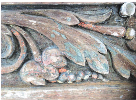
Blotlagt detalje på overgangsremmen. Resterne af de gamle farver ses endnu tydeligt om end sporadisk. Foto: Finn Strabo.
