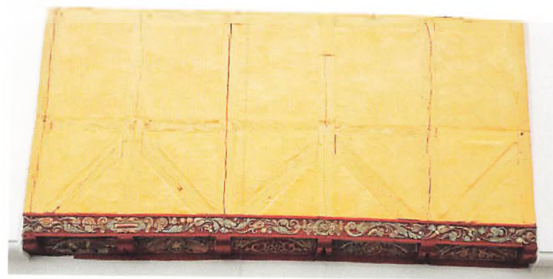
Den restaurerede bindingsværksgavl efter udført arbejde. Foto: Finn Strabo.
