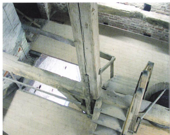
Andet stokværk i kirketårnet. Til højre ses en vandhane og et vandkar til brandbekæmpelse. Foto: Torben Bill-Jessen.
