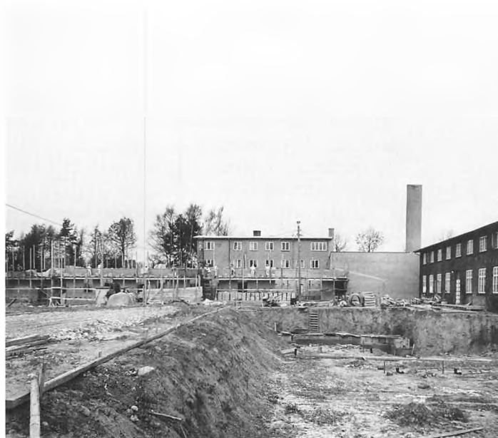
Steen Ejler Rasmussens bygninger under opførelse. 1965.
