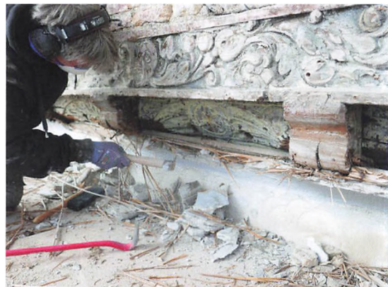
Mureren i færd med at afdække den skjulte overgangsrem. Foto: Finn Strabo.
