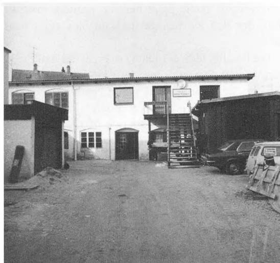
Gl. Banegårdsvej 4. Den tidligere fabriksbygning, V. Hjorth & Co's trævarefabrik.
