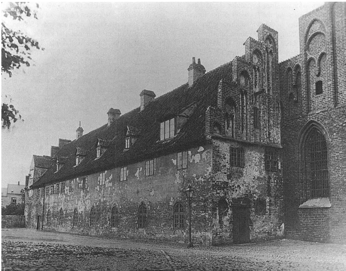
Karmeliterklosterets vestfløj før den gennemgribende restaurering 1901-07. Helsingør Latinskole havde til huse i stueetagen, mens Henrich Steffens var dens elev. Sammenligner man med forholdene i dag, forstår man, hvorfor han taler om at komme til klosteret ved at gå ned fra kirkepladsen (se note 16).
