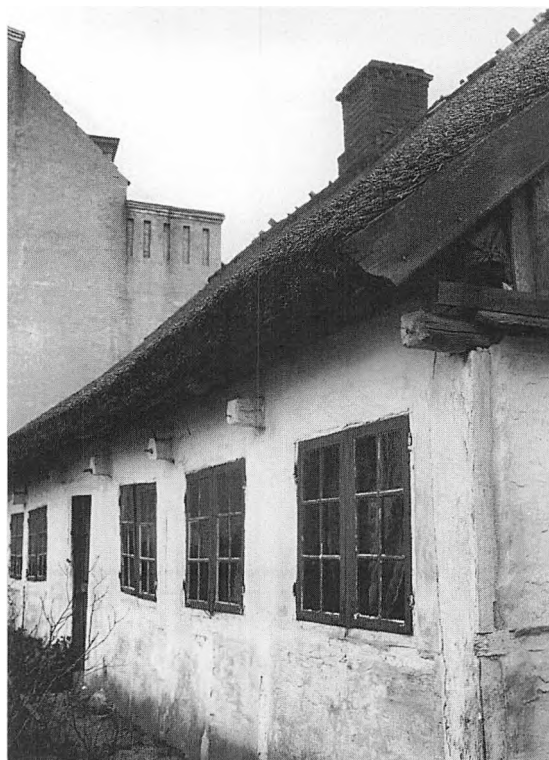
Fig. 2. Husets sydfacade, set på langs fra øst. Bl.a. ses i forgrunden, hvordan gavlens bjælke og sidebånd er samlet med hjørnestolpen. Foto: H. Zangenberg 1927.
