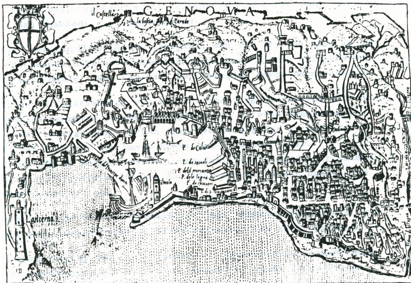
Det store fyrtårn på Genovas mole blev bygget i 1643
