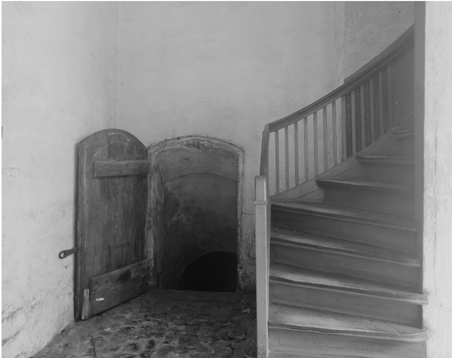
Nedgangen til celle i Stokhuset. Fotograferet i 1938 lige før nedrivningen af de gamle fængselskompleks. Københavns Museum.
