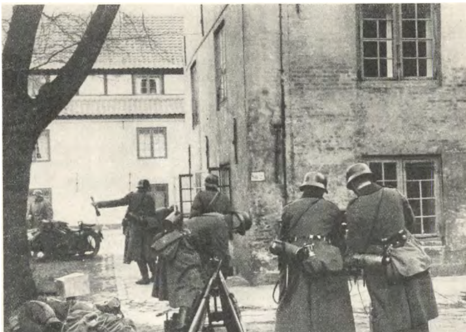
Kastellet er overrumplet, Gangsterne er rykket ind, og de begynder nu at etablere sig. Først skal man have trukket de nødvendige Telefonledninger — uden at man dog tør slippe Haandgranaten! Der kunde jo finde Overraskelser Sted, som forstyrrede det samfundsnyttige Arbejde!
