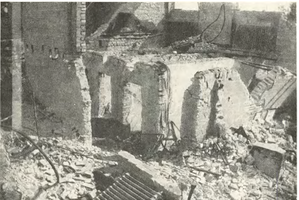
Fangecellerne under den bombede Husmandsskole.
