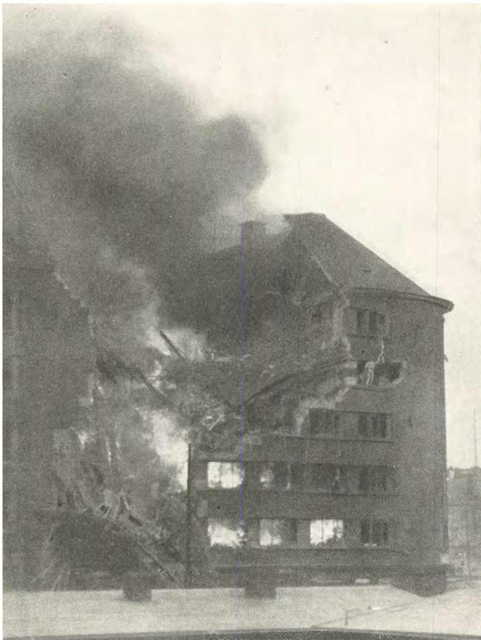
En R. A.F.-Bombe har flænget hele Shell-Huset op, og Ild og Røg vælder ud af Bygningen.
