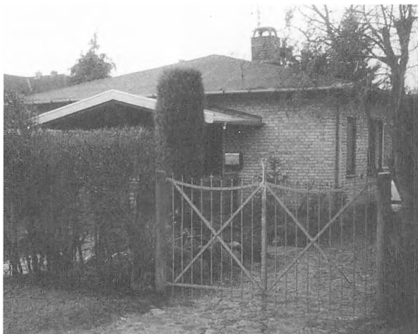
Nils og Kirsten Thorssons hus på Skovvej (nuv. Gl. Skovvej) i Espergærde. Det gik med Thorsson, som med så mange andre: Det der oprindeligt var en sommerbolig i Espergærde, blev til sidst helårsboligen. (Foto: K. Damgaard, 1999).
