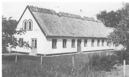
Stuehuset på Holmegaard inden ombygningen. (Foto udlånt af Kirsten Westergaard).
