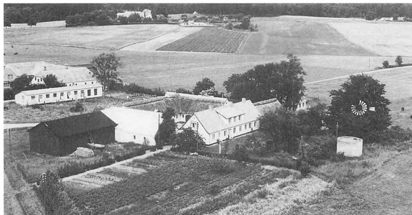
Holmegaard fotograferet omkring 1950, hvor stuehuset netop er renoveret. Bemærk Bistrup Vandværk til højre for Holmegaard.
