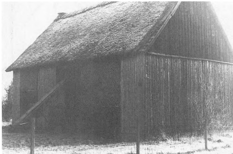
Den gamle lade ved Valdemarslund med det særegne fletværk af enebær og lyng - nu kun bevaret meget få steder. (Foto: Per Topp, 1981),
