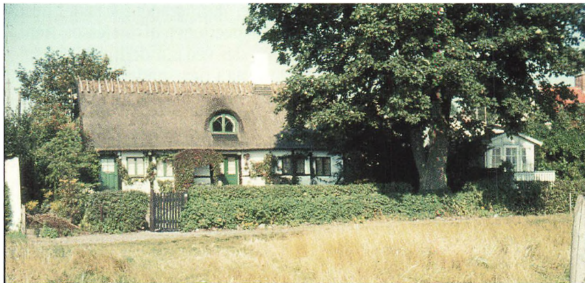
"Strandhytten" er ifølge BBR-registeret opført i 1827. Hvis denne oplysning er korrekt, var det muligvis ikke i dette hus, at Jens Lind boede. På den anden side viser kortet fra 1810, at der da lå et hus på nøjeagtig samme sted, som i dag. BBR-registers oplysninger bygger dog ikke på dokumenterede kilder og kan altså også være fejlagtig. (Foto: 1960)
