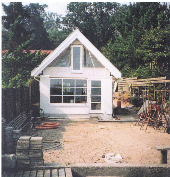
Det nye sommerhus under bygning i september 2002.
