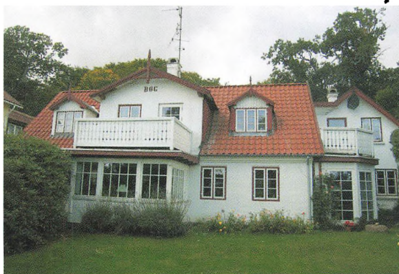
Det store træ i haven foran ejendommen er nu forsvundet, og man ser bedre selve hovedhuset samt den nordre længe, der nu er sammenbygget med hovedhuset. (Foto oktober 2005)
