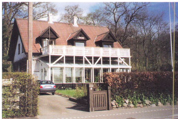
De karakteristiske udsmykninger på taget er forsvundet, og facaden mod Øresund har ændret en del karakter, efter at der i 1992 blev opført en udestue mod øst. Huset bærer dog stadig det gamle navn "Lisebo", men hvem Lise var, er ikke sikkert - måske sagfører Ortmanns hustru, der egentlig hed Elisabeth? (Foto: maj 1999)
