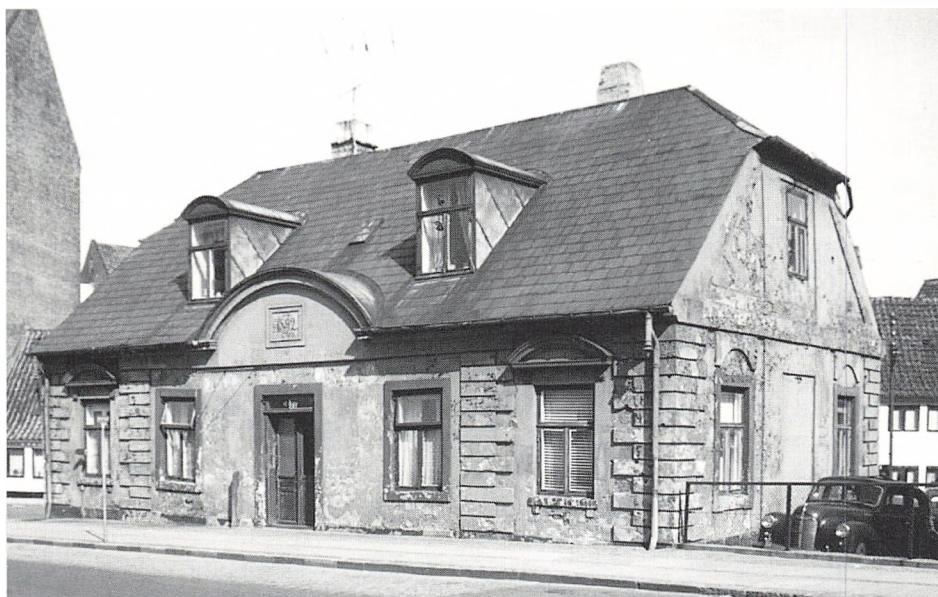
Bygningen fotograferet 1959, da den stod forfalden, men stort set uændret i sit ydre siden Slagterstiftelsen i 1892 lod den ombygge og indrette til 6 friboliger. Helsingør Kommunes Museer.
