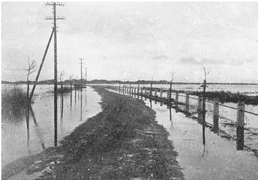
Landevejen Tønder—Sød for afvandingen.
