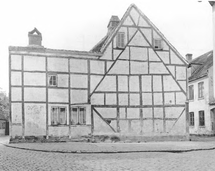
Munkegade 13 fotograferet fra øst. Munkegade ses til venstre og Graabrødrestreæde til højre for bygningen. Bindingsværket afslører, at en nu nedrevet bygning tidligere (se kortet side 69) stødte op til gavlen.
