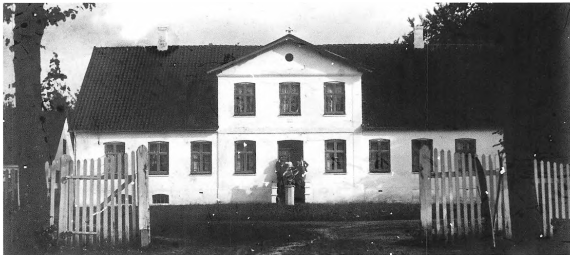
Kjeldsbjerggaards hovedbygning fotograferet i begyndelsen af 1900-tallet. Antagelig er det familien Svendsen, der er opstillet på trappen. Familien, der havde ejet gården i mange generationer, solgte ejendommen i 1911.
