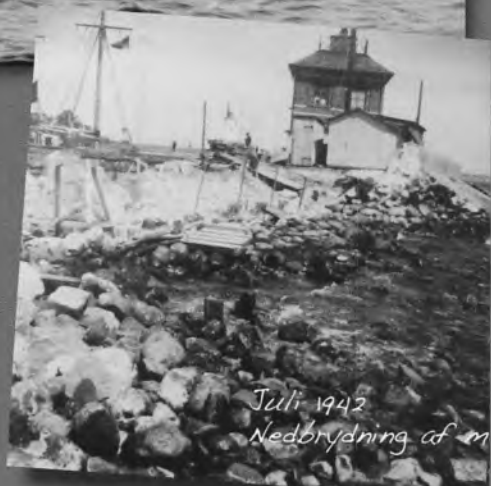
August 1942 Sprængning af kajmurens beton
