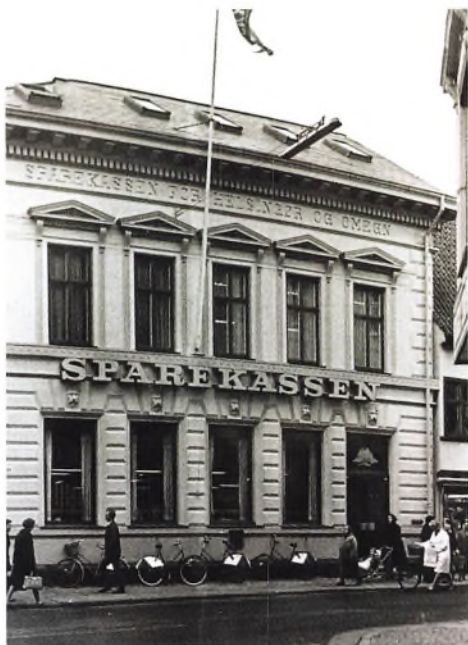
Sparekassen havde sit domicil på hjørnet af Stengade og Stjernegade i en bygning, man i 1883 havde opført til fornalet. Fotografi: Kenno Pedersen 1971.
