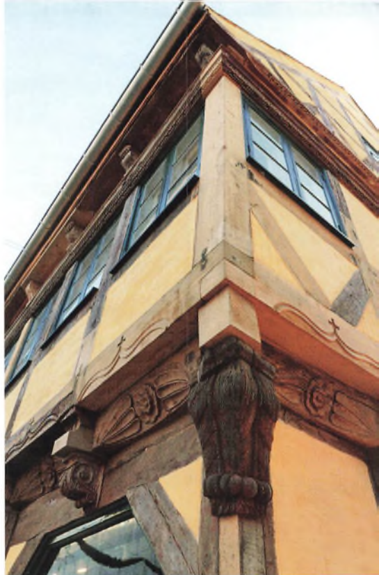
Detalje af facaden efter restaureringen. Foto: Finn Strabo.
