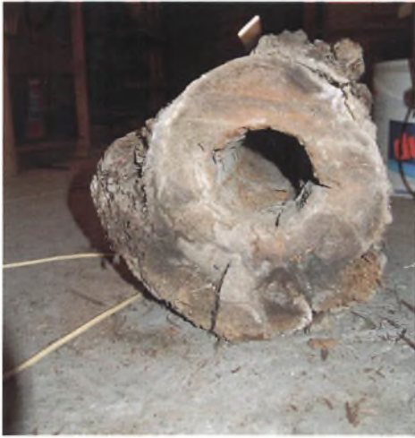
Da en af mine venner gravede ud til kældere i sit nybyggede hus på Rønnebær Allé, stødte han på denne gamle vandledning. Foto: Torben Bill-Jessen.
