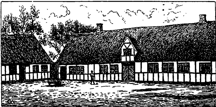
Bormholm før Ombygningen 1915. (Efter Fotografi).
