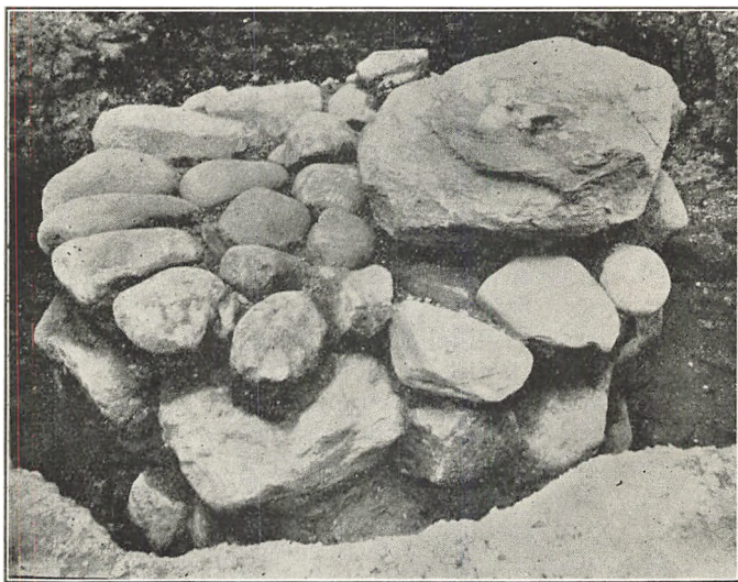
Store Pillefundament i Østfløjen.
