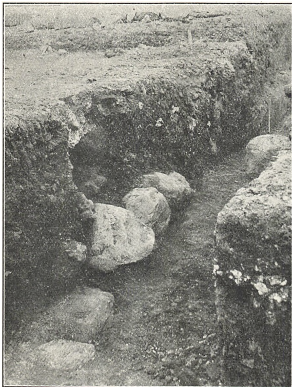
Nordfløjen. Kanten af Fundamentet for den mod Klostergaarden vendende Side af Korsgangens Ydermur. Fotograferet fra Vest mod Øst.
