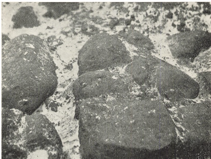
Fig. 2. Adskillelse mellem Kirkefundamentet og Støttepillen. (set fra Nord).
