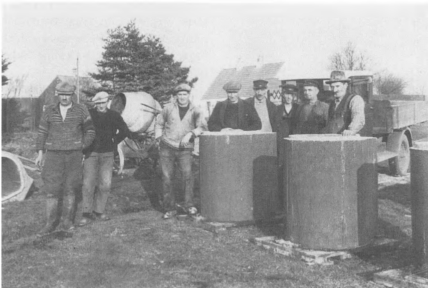
Kloakarbejde på Engtoften i Skjern. Gennemløbsbrøndene stod i mange år og ragede op over engdraget inden vejen ved opfyldning blev etableret.
