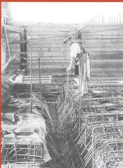
Her ses jernarmeringen, før den dækkes af beton.
