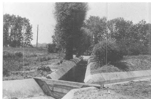
Anlæggelsen af vandværket betød, at Lille Vejleå blev foret med beton, for at forhindre åvandet i at sive ned og forurene grundvandet.
