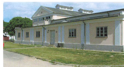
Filterbygningen blev opført i 1922 i en nyklassisk stil. Her filtreres vand fra Taastrup-Valby boringerne, fordi vandet indeholder jern. Fra filterbygningen ledes det til reservoiret.
