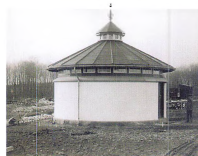
Den færdige samlebrøndsbygning udformet over jordhøjde i samme form som bygningsværket under jordhøjde. Man er ved at rydde byggepladsen. Arbejdsskuret i baggrunden bliver også fjernet.
