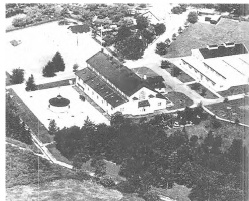
Midt i fotografiet ses maskinhuset, til venstre samlebrøndsbygningen og bagved hanekammerbygningen med det store areal med reservoiret. Skråt bagved kan man se mesterboligerne. Den store 1. mesterbolig er ikke synlig, men den hører med til de bygninger, som blev opført i 1908. Den store bygning til højre i billedet er filterbygningen, som blev opført i 1922.
