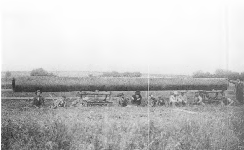
Støbejernsledningerne forbandt Thorsbro med København.
