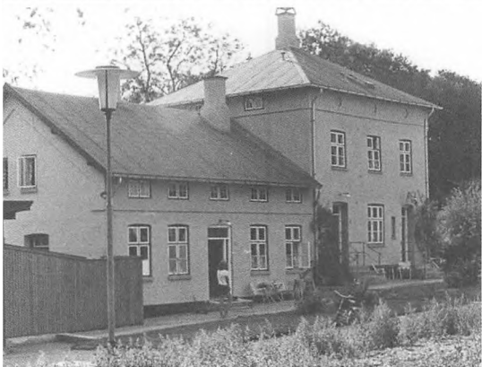
Store Mølle blev indrettet til 3 lejligheder, da værket kom i drift. Her boede maskinmestre, motorpassere og reparatører.
