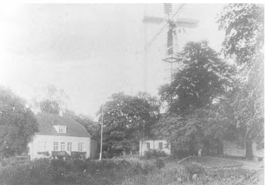
Vindmøllen ved Pile Mølle blev sat op efter Værket ved Thorsbro var etableret, fordi vandstanden sank i Lille Vejleå, så møllen ikke kunne drives ved vandkraft længere.
