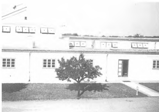
Filterbygningen nogle år efter den var taget i brug.
