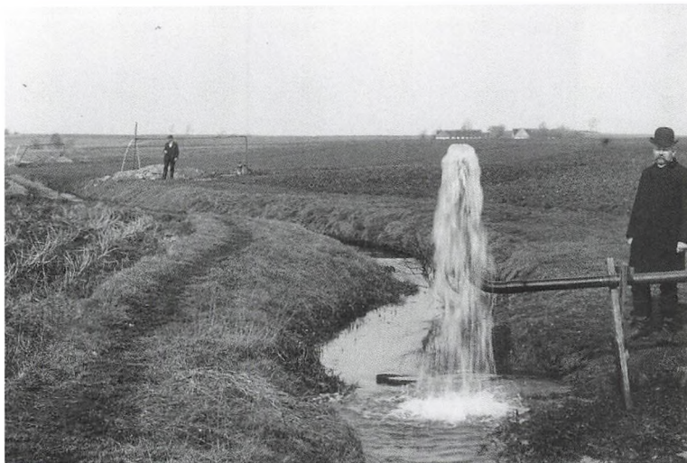
Vandforsyningens ingeniører og medarbejdere foretog prøveboringer i 1904 for at teste vandkvalitet og vandspejlets højde.
