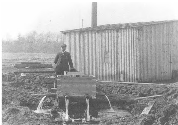
Der blev foretaget mange prøveboringer forud for anlægelsen af værket.
