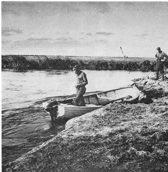
Oversvømmelser i august bevirkede, at entreprenørfirmaet måtte bruge både til transport af gravemestre ud til maskinerne. Her er ingeniør Rohde, der er daglig leder af landvindingen, ved at gøre klar til sejlads på den.
