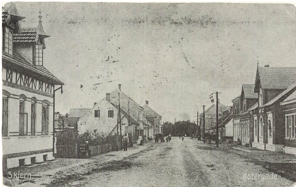
Østergade ca. 1902. Til venstre ses bygningen, hvor Østergades Foto ligger.
