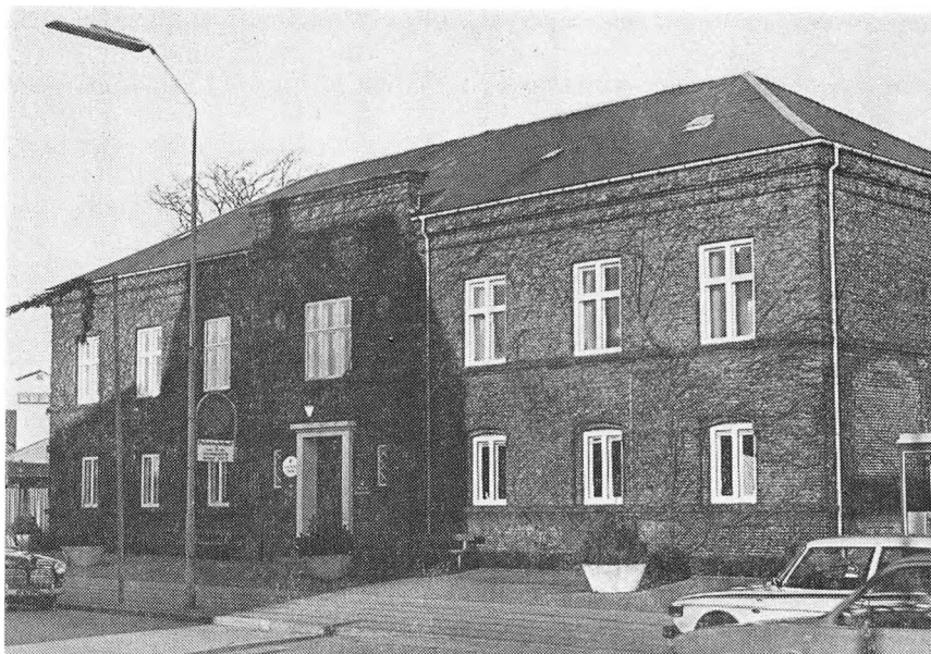
Ting- og arresthuset i Bredgade i Skjern er bygget i 1884. Siden 1928 er arresten nedlagt, så nu er det kun tinghus og politikontor.
