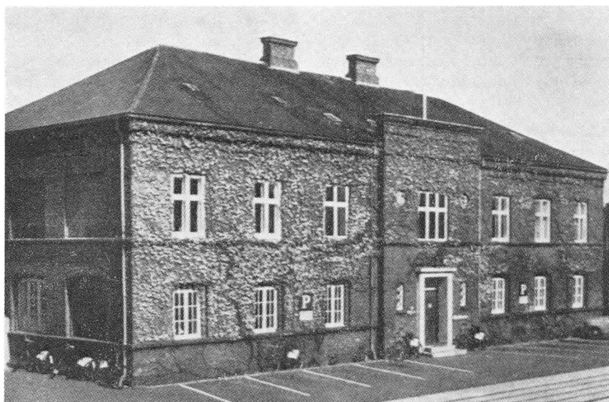
Ting- og arresthuset i Skjern, bygget 1884.
