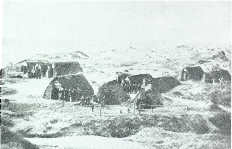
Fiskerboder ved Vejrs strand 1876. Efter fotografi på Varde museum. I forgrunden Ålegrøften og stejlepladsen. Sammenlign s. 75. Se også s. 58 og 61.
