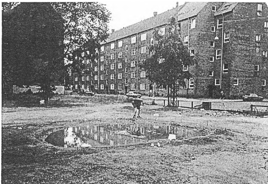
Oprydning omkring det nye gadekær (sommeren 1991)
