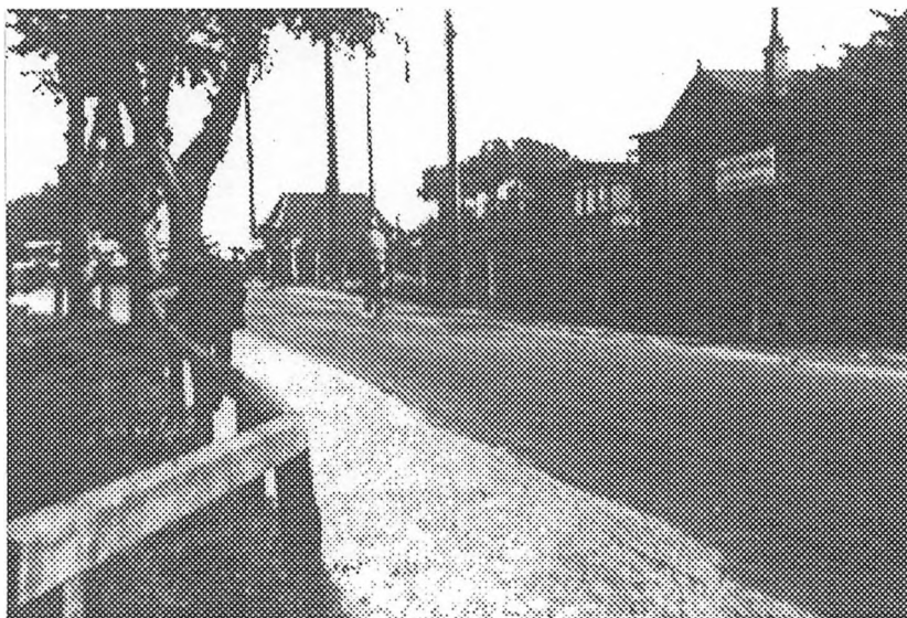
Jernbaneoverskæringen ved Vigerslevvej. Huset i midten er Vigerslev blokpost
