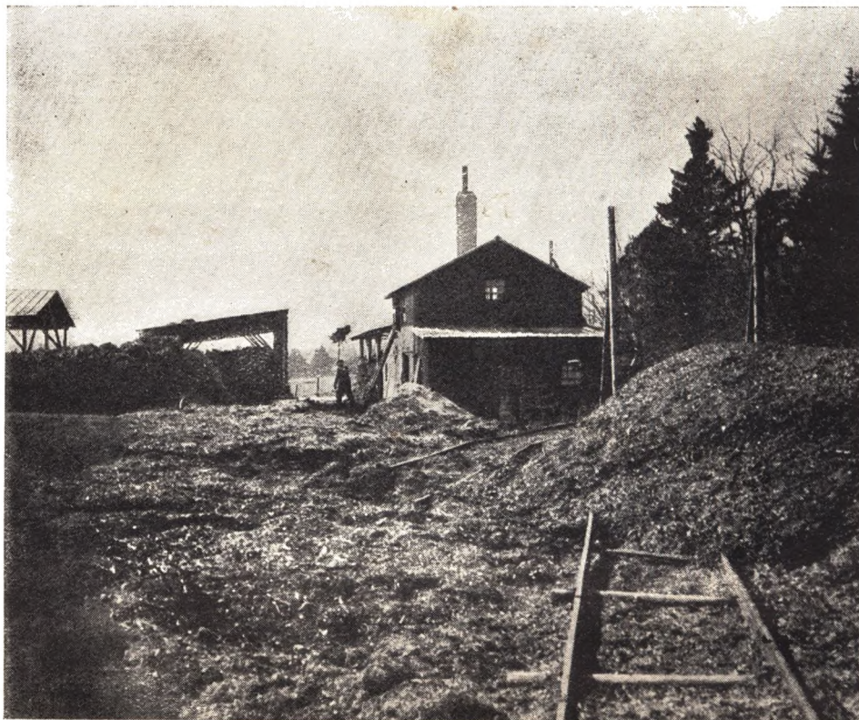
Bjergfyrrens Kviste hakkes og koges i denne lille Fabrik, for at man kan udvinde den duftende Olie.
