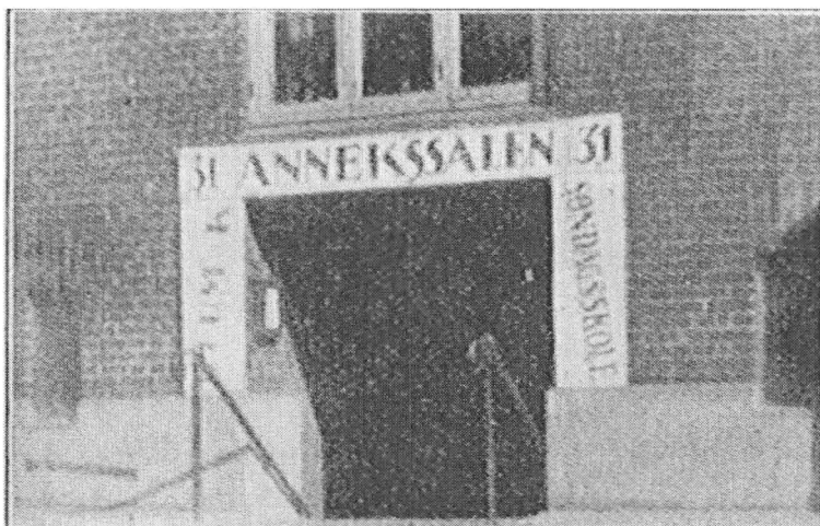
Annexsalen på Vigerslevvej
