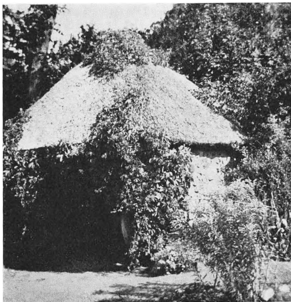
Dagskole fra katolsk tid ved voldgraven, opført af kildekalk og kampesten, tækket med rør. Erik Nielsen skriver 1537: Vi har bygget hus, og broder Jens har som tilforn hørt børnene i havehuset ved åen. Foto 1969.
