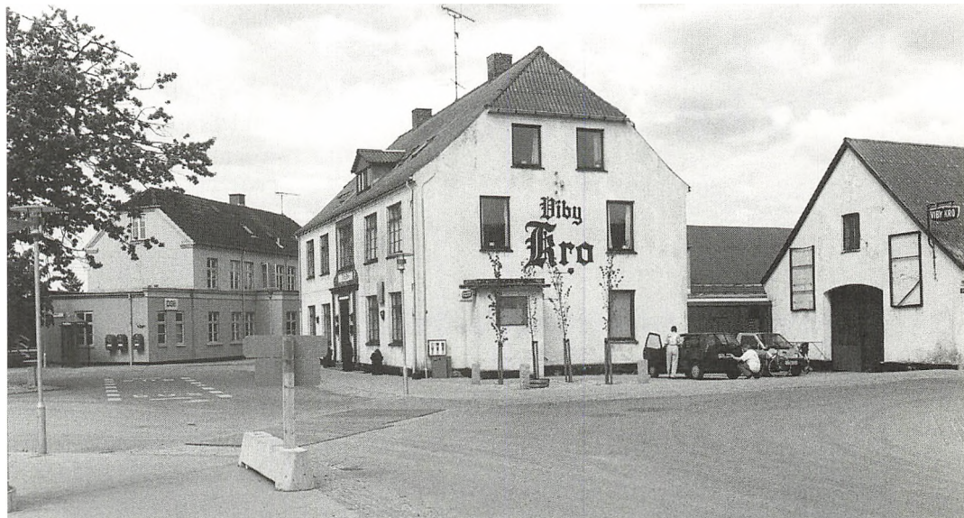
Viby Station, kro og rejsestald
