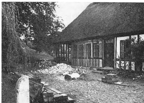
Møllens ældste del under restaurering. (Foto: Odder Museum).
