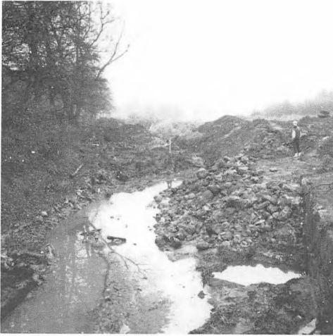
Billedet er taget fra vejbroen over Lilleåen. Til venstre i billedet ses udgravningsfeltet med resterne af vandmøllen fra 1700-tallet. Til højre i billedet området, hvor den yngste mølle, opført o. 1912, lå. (Fot.: F.H.M.)
