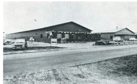
»Herborg«s nye fabrikationshal.
