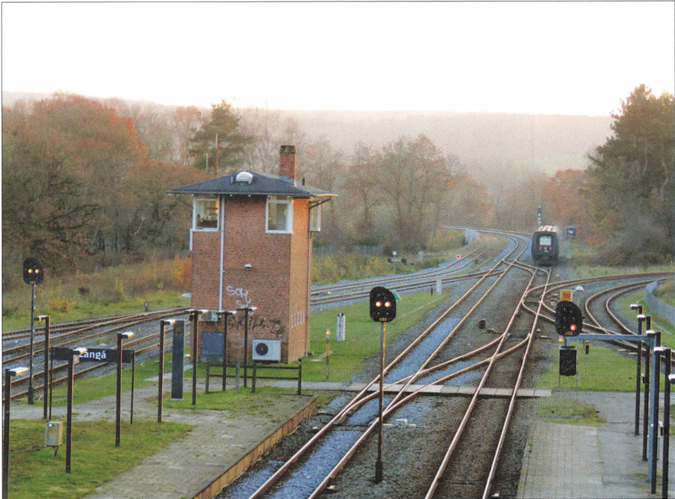
Udkørsel fra spor 2 over Gudenåen, der i sin tid blev bestemmende for stationens placering. Sikringsanlægget i kommandoposten sørger for, at der straks bliver rødt signal bag det kørende tog. Foto: Peter Poulsen
