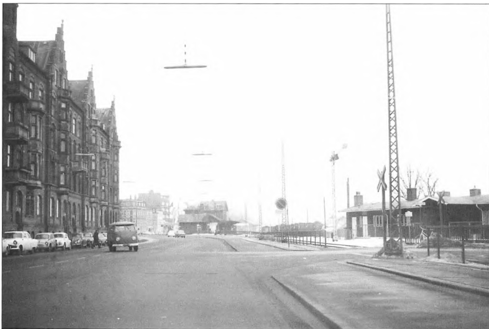
Signalerne ved Århus Ø var armsignaler. Når armen på signalet som her viste skråt opad, betød det kø. Var armen vandret, betød det stop. Vejen, der krydser banen, er Gotlandsgade. Her var der ingen blinklys eller bomme. Foto: J. Guldbæk Christensen/Arkiv JMJK.
