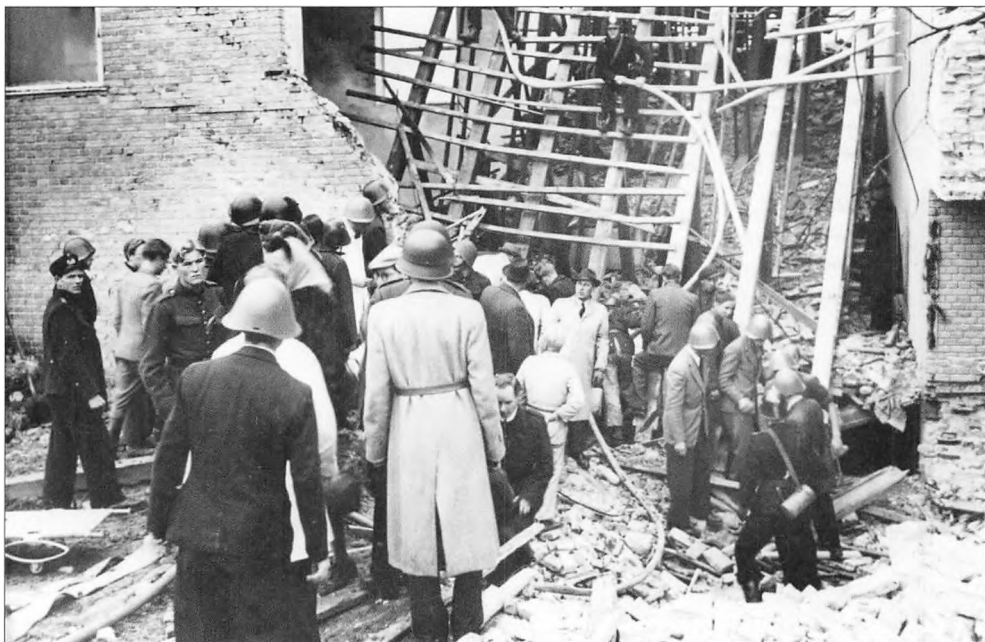
Redningsarbejde i Universitetets hovedbygning. Tre arkitekter, heriblandt C. F. Møller, blev bjærget i levende live. 10 bygningsarbejdere blev dræbt, men ingen studerende.
